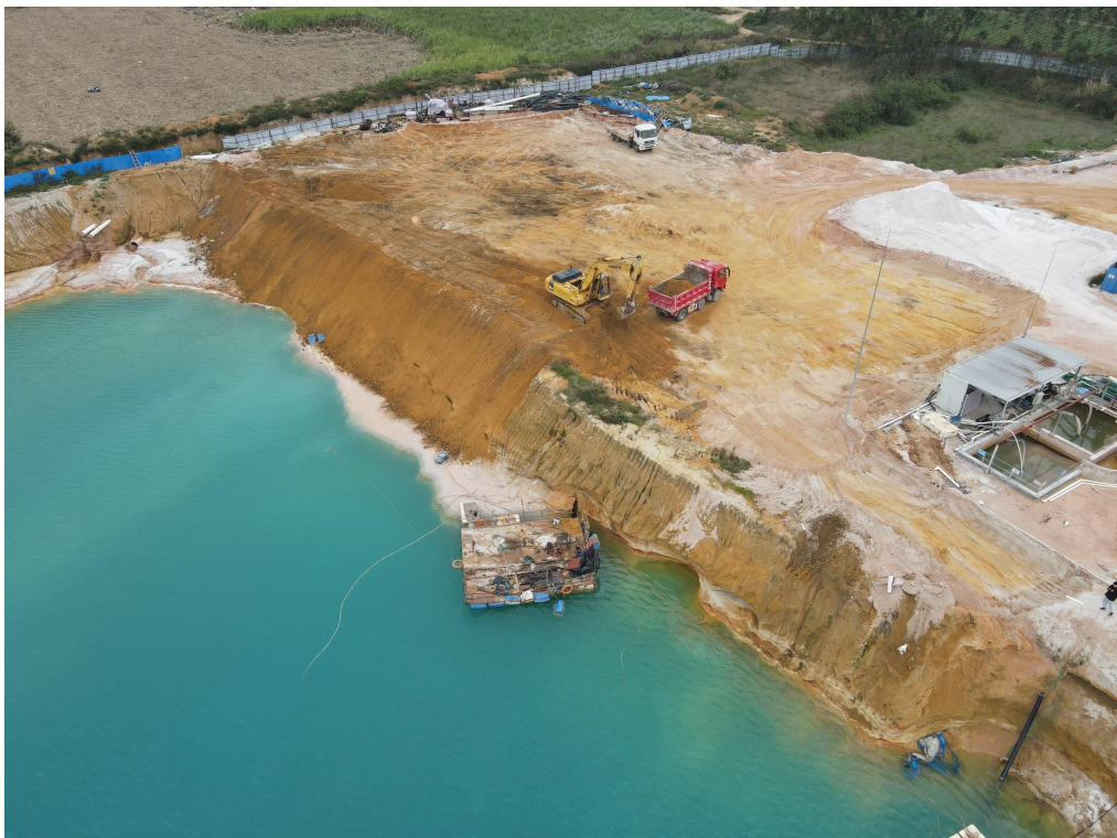
图 2-7 采场南部修整边坡（前期复垦）
