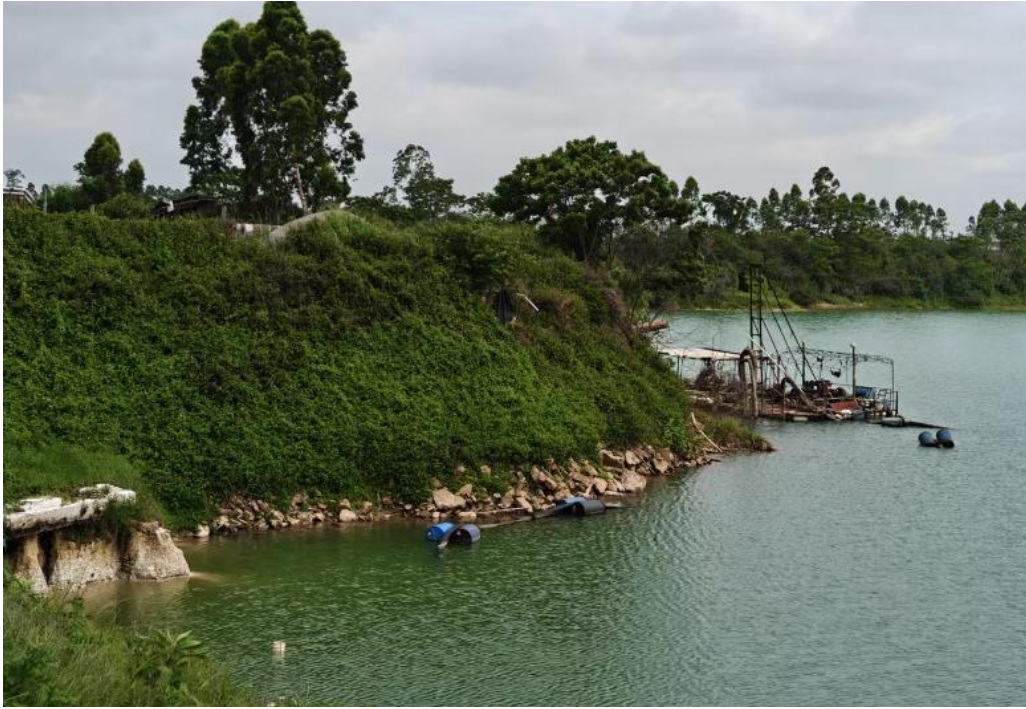
图 5-4 抛石护脚工程现状
