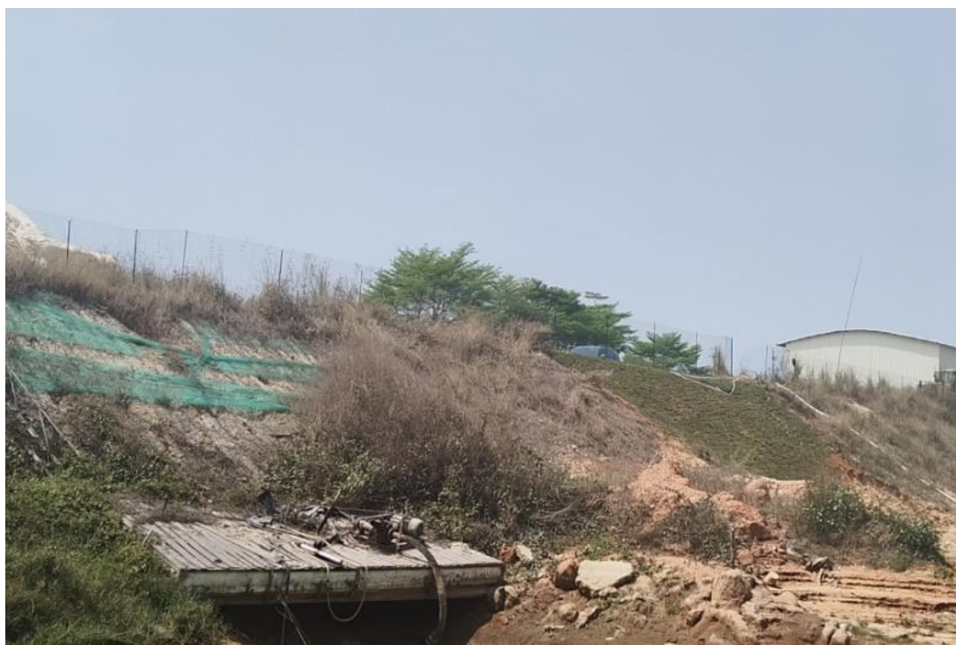
图 5-7 现状露天采场南部边坡
