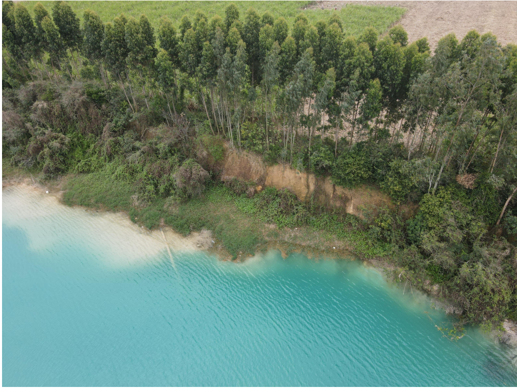
图 2-6 采场东部现状（前期复垦）
