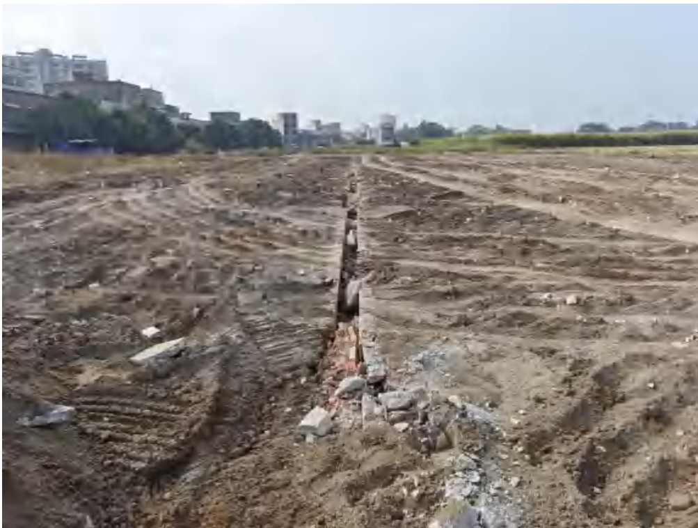
临时用地拆除照片
