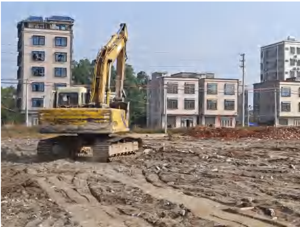
临时用地拆除照片
