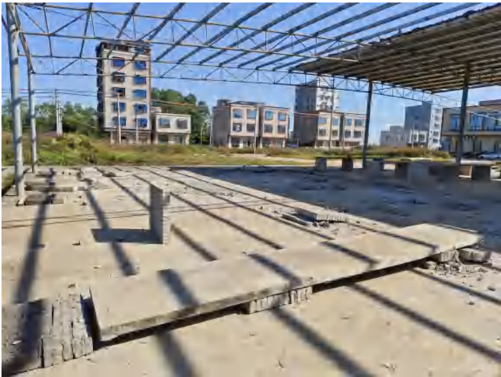
临时用地拆除照片
